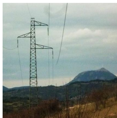
La ligne très haute tension qui n'est pas concernée
